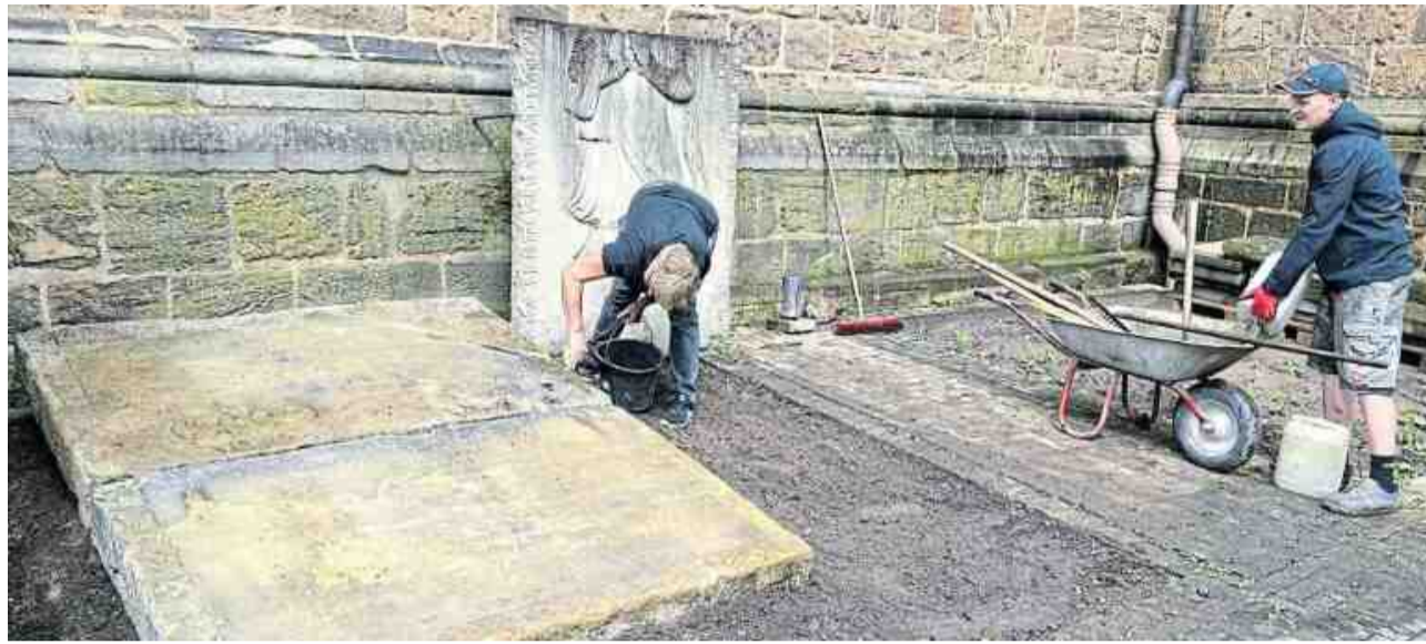
Steinmetzin Gabriele Stendel-Merks und Steinmetz Florian Merks führen die letzten Instandsetzungsarbeiten an der mehr als 200 Jahre alten Grabplatte des evangelischen Domherrn Ernst Freiherr von Ledebur aus. Foto: privat
