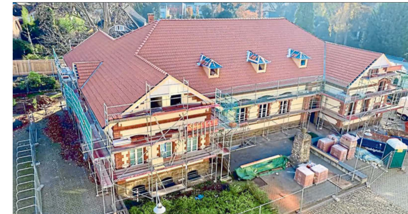
Zurzeit wird die Fassade der ehemaligen Mensa saniert.
