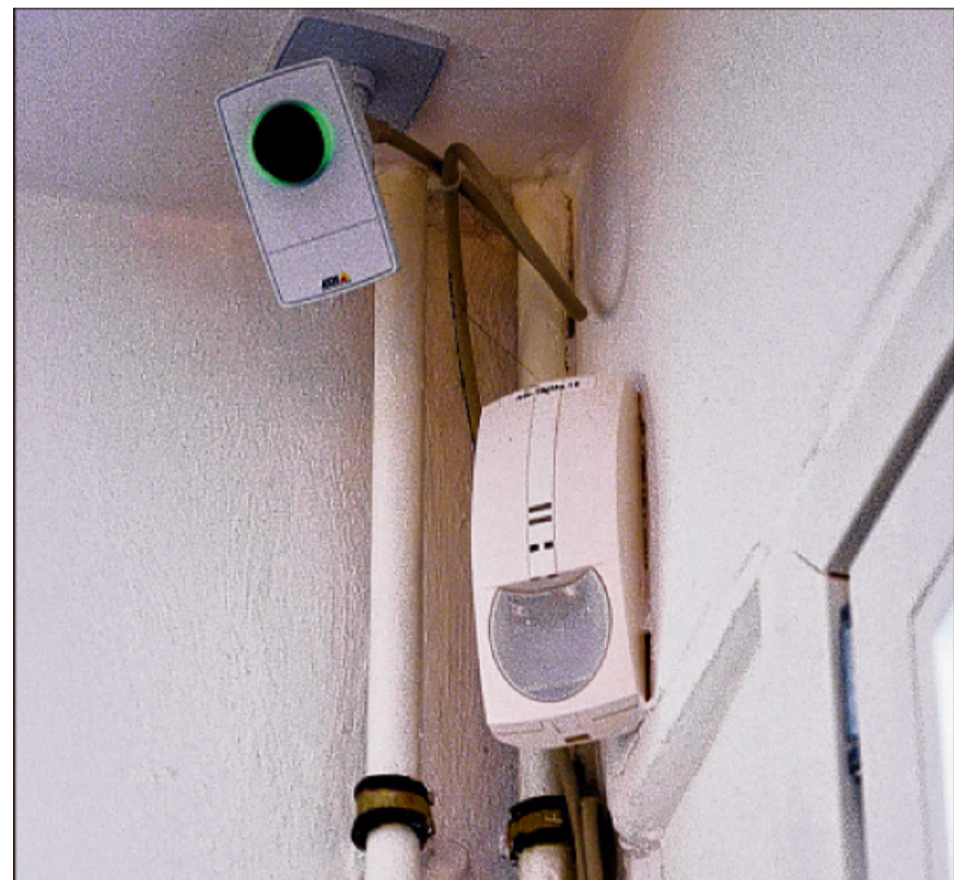
Sicherheit im Museum: Bewegungsmelder und Kameras gehören zur technischen Ausstattung, um Exponate zu schützen. MT-Foto: Langenkämper
